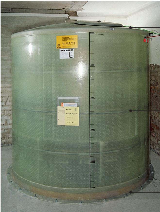
Abbildung 12: Auftriebsicherung bei standortgefertigtem GFK-Öltank
