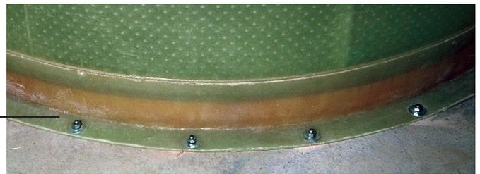
Detail: Verankerung des verstärkten Bodens im Beton
