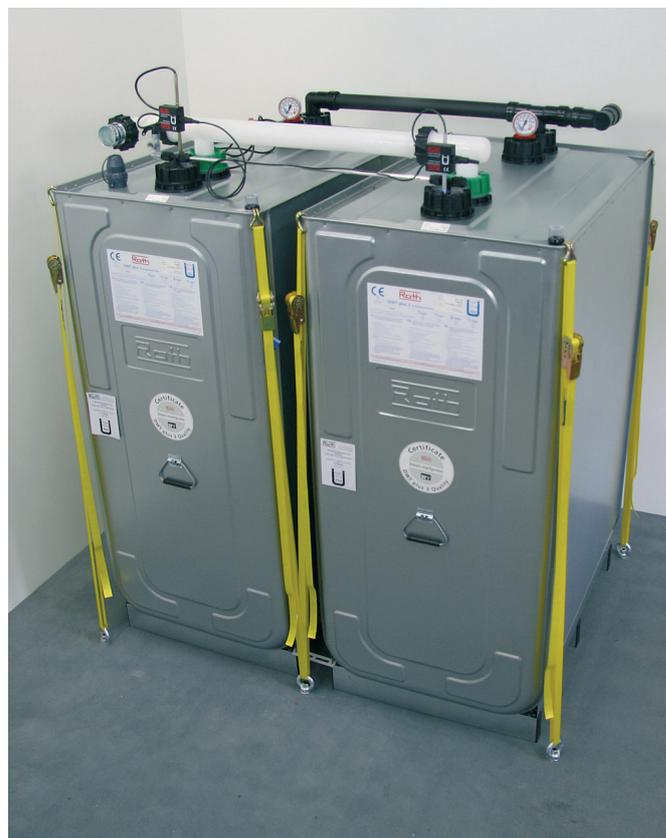
Abbildung 14: Hochwassersichere Aufstellung (Bsp. Fa. ROTH)
