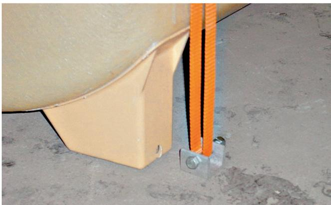
Abbildung 18: Hochwassersichere Aufstellung (Bsp. Fa. CEMO)
