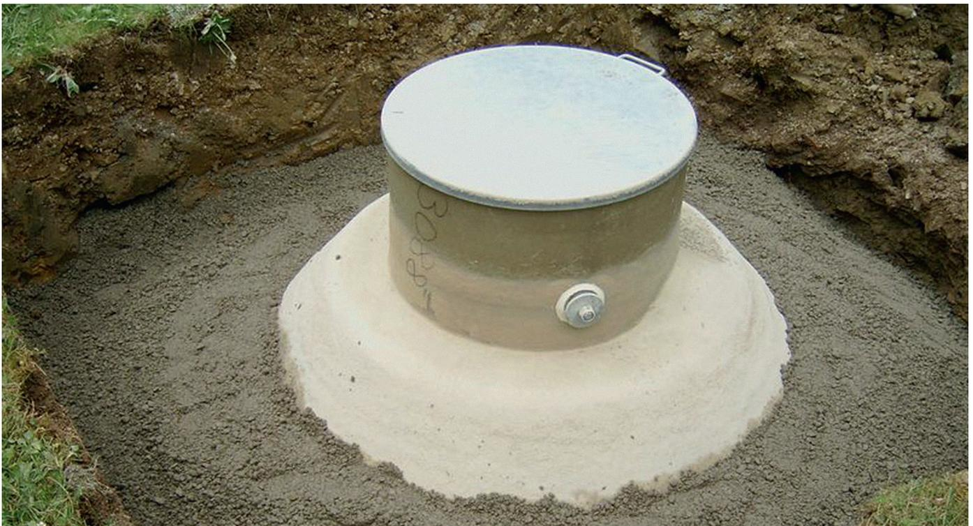
Abbildung 4: Auftriebsicherung unterirdischer Öltank (GFK-Tank)
